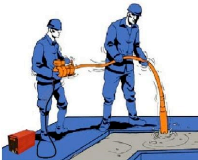
Рис. 1 Механический вибратор, подключаемый к трансформатору
